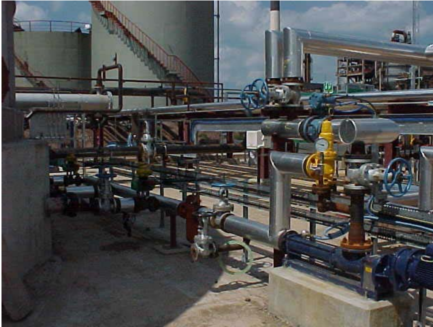
Ombouw tankopslag tot waterzuivering
